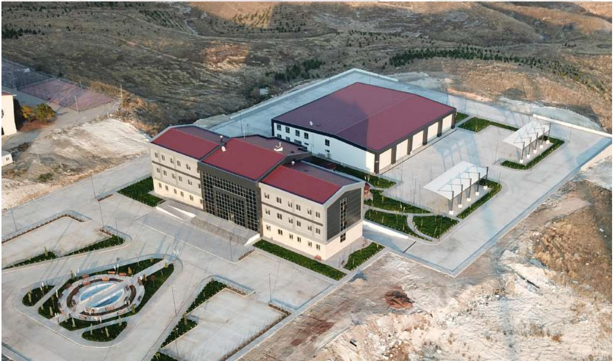
Araç Hangarı ve Yapı İşleri Binası
