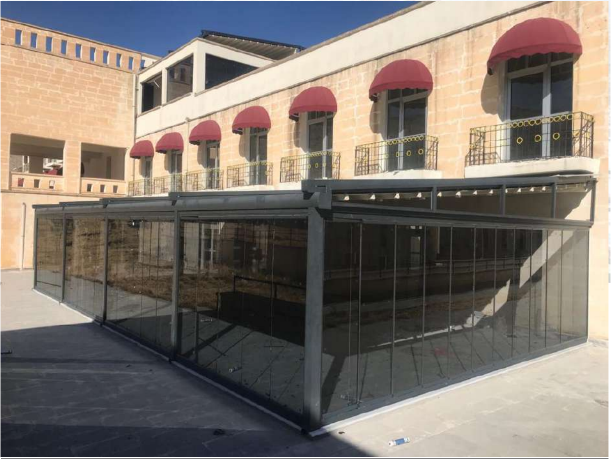
Hasankeyf Uygulama Oteline Tente Sistemi ve Muhtelif İmalatların Yapılması İşi tamamlanmıştır.
