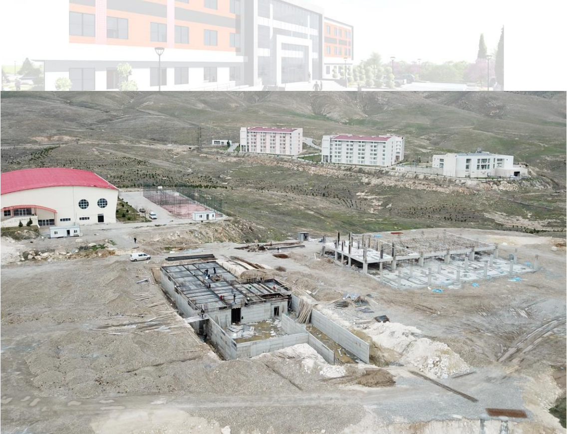
Araç Hangarı ve Yapı İşleri Binası
