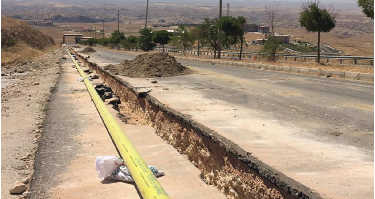
Doğal Gaz Ana Hat Yapım İşi
