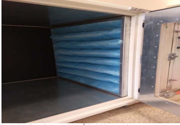
Şekil 3. Filtrenin Boş Hücre İçindeki Montajı
