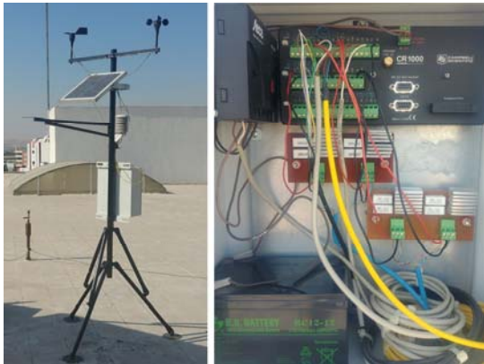
Şekil 2. Meteoroloji istasyonu ve data logger
