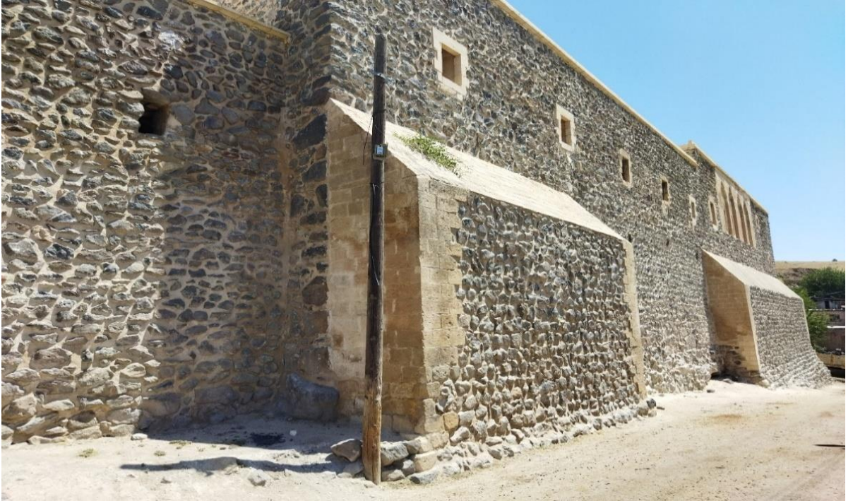
Şekil 7. Güney cephesinden görünüm, 2022
