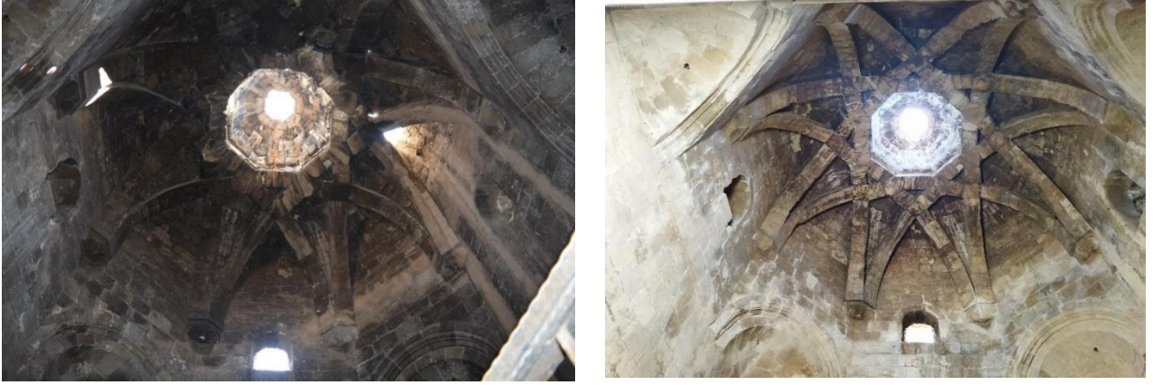
Şekil 17. Kilisenin içinden görünüm (Soldaki foto 2017, Sağdaki foto 2022)
