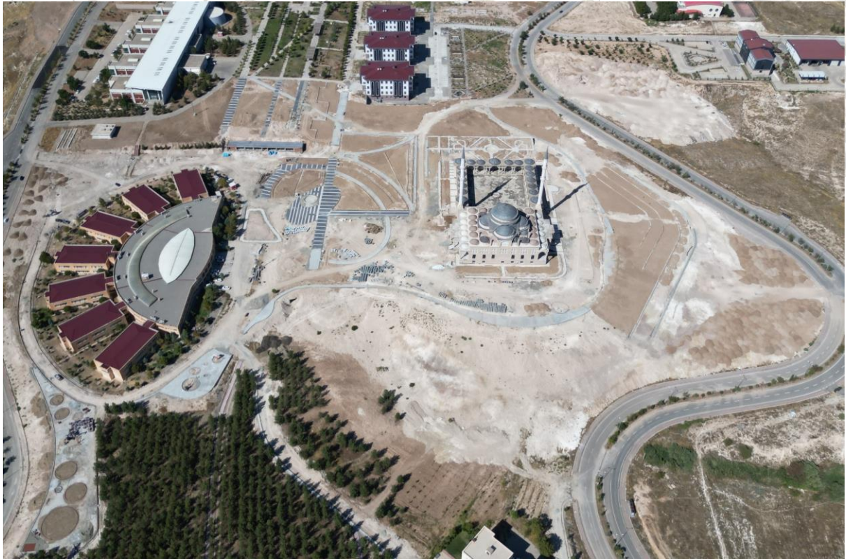
2.Etap Peyzaj Yapım İşi
