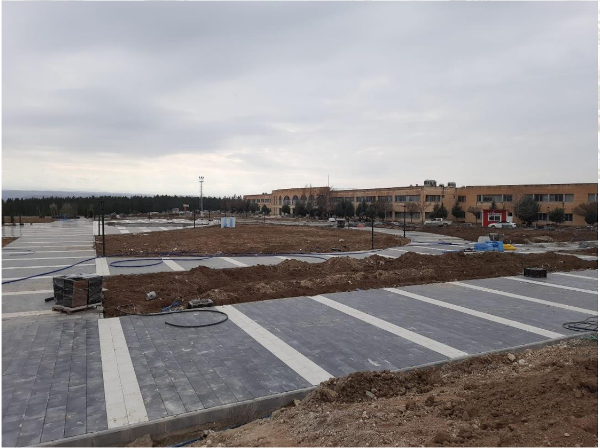
2.Etap Peyzaj Yapım İŖi
