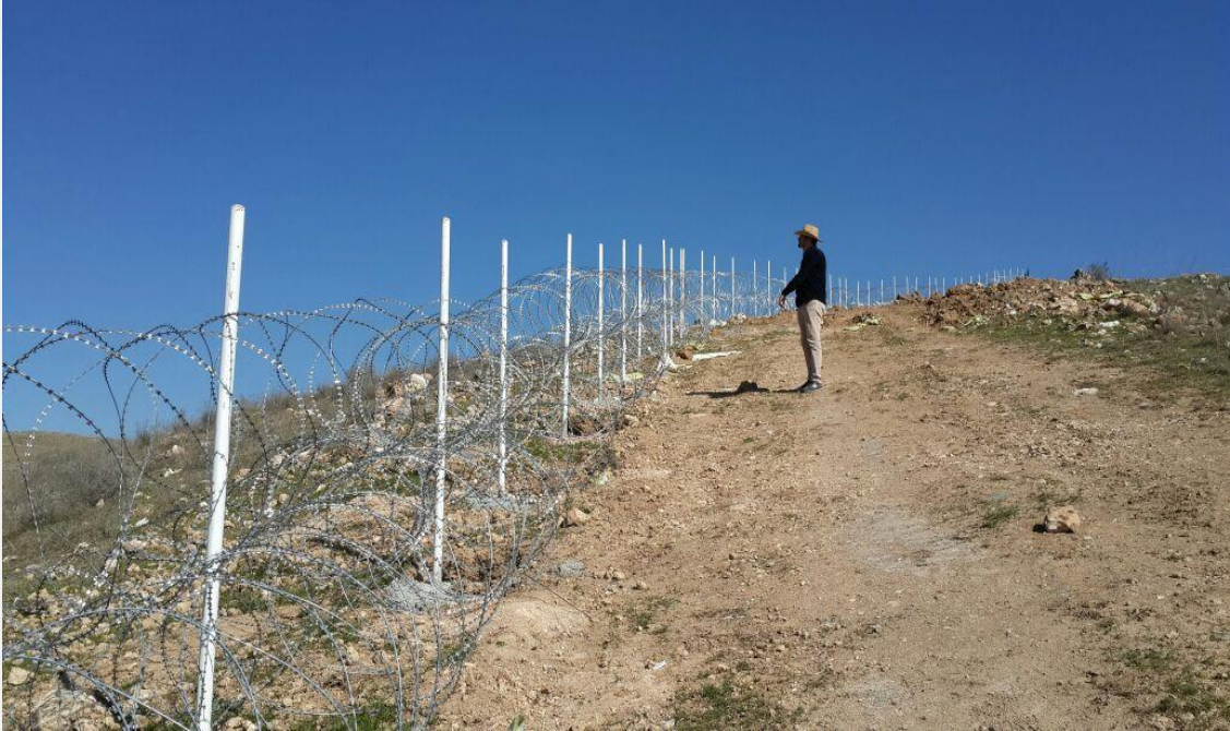
Batı Cephesi Helezonik Jiletli Tel Yapım İşı
