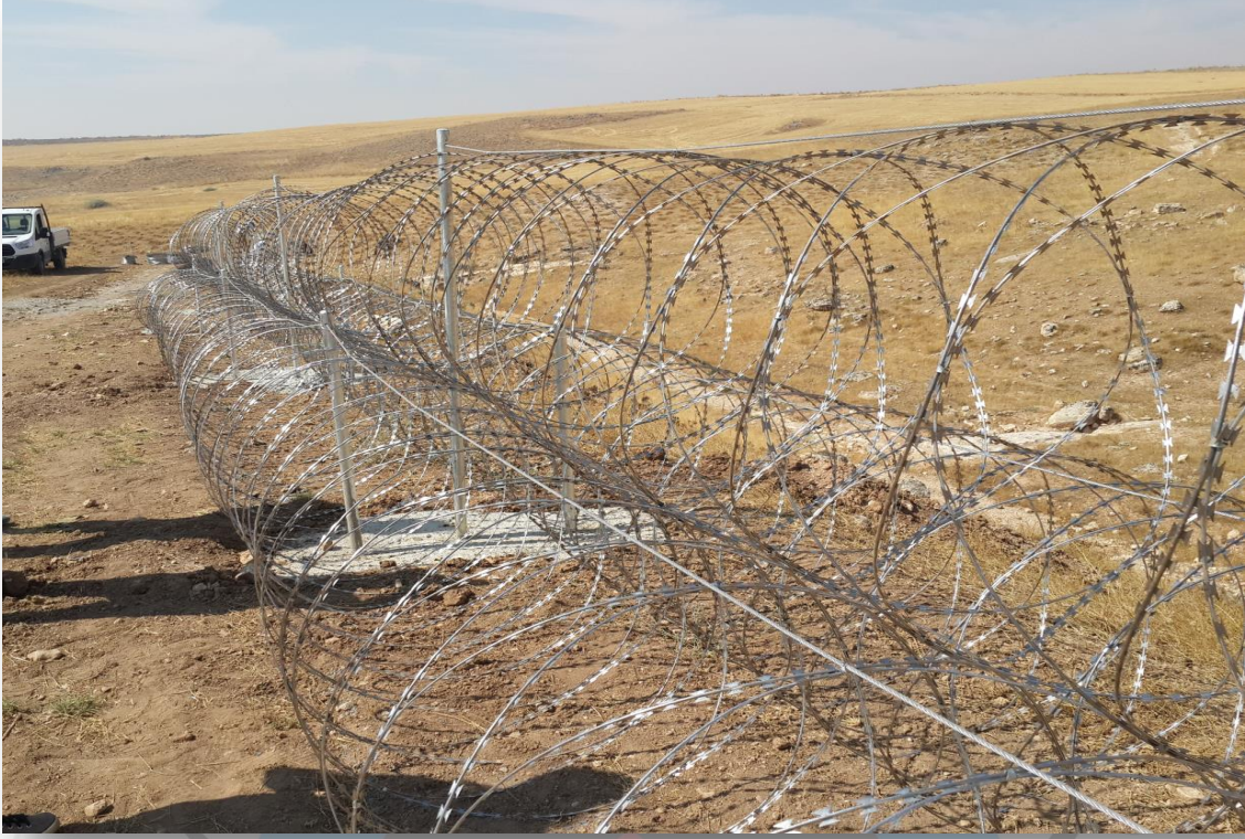
Batı Cephesi Helezonik Jiletli Tel Yapım İşı
