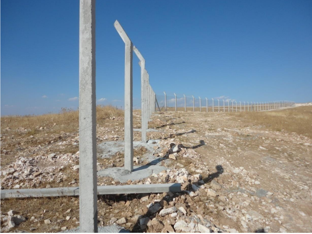
Beton Direkli Kafes Tel ve Helezonlu Jiletli Tel ile it Yapım İři
